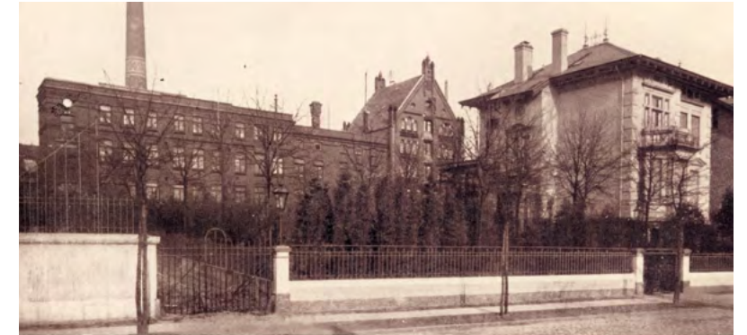
P. Beiersdorf & Co., Chemische Fabrik, Hamburg. Teilansicht
